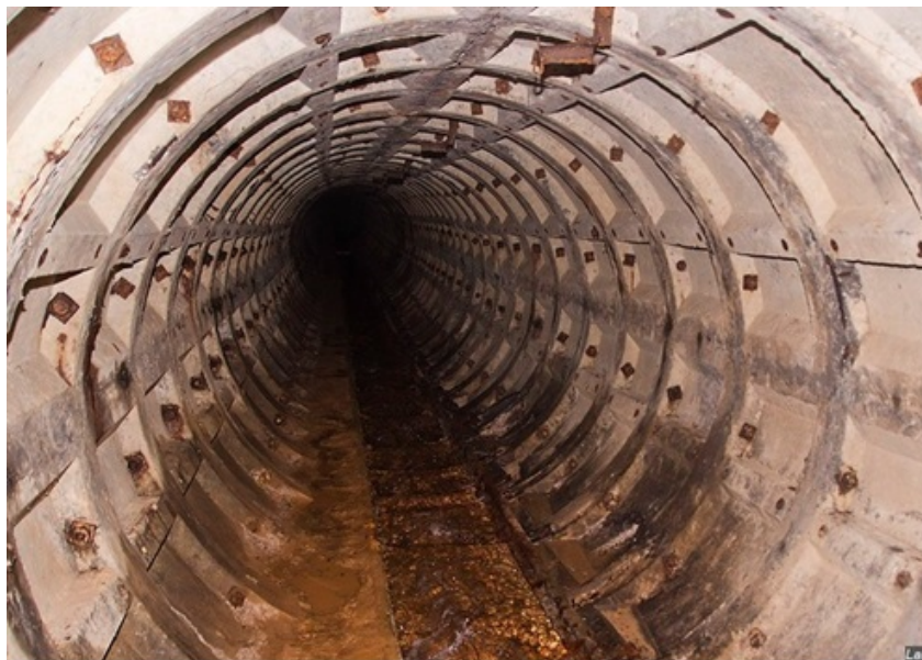
Рисунок 1 – Укрепленный подземный тоннель в массиве горных пород
